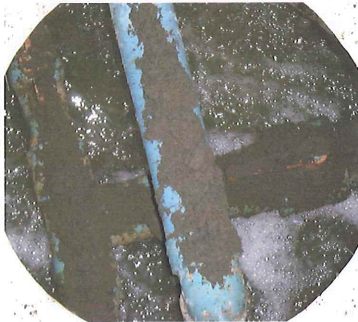
รูปที่ 2.1.2 การเติม Seed ตะกอนแบคทีเรีย ชนิดแห้ง ลงในบ่อเติมอากาศ
